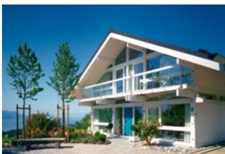
KNX für vernetzte Systemhäuser
